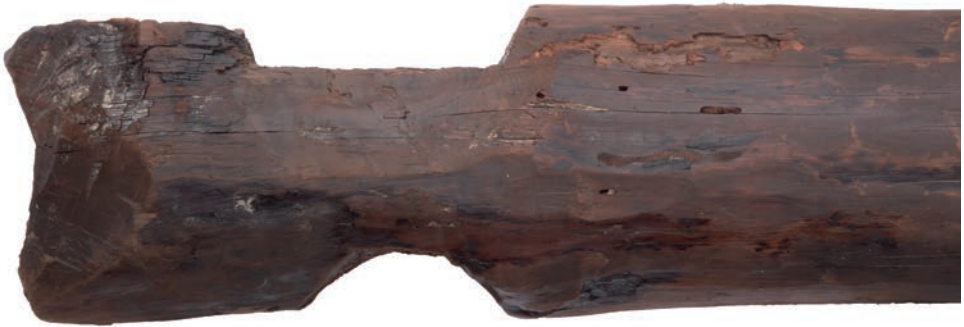
Abb. 11. Ursprünglich in der Blockhausarchitektur verwendeter Balken mit Aussparungen (Foto: Nerik Datenbank).
