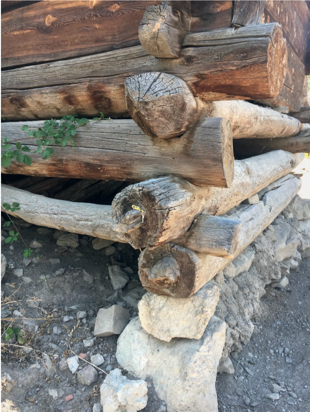
Abb. 12. Fundamentecke eines hölzernen Getreidespeichers aus Altınkaya Köy (Foto: Rainer Czichon).
